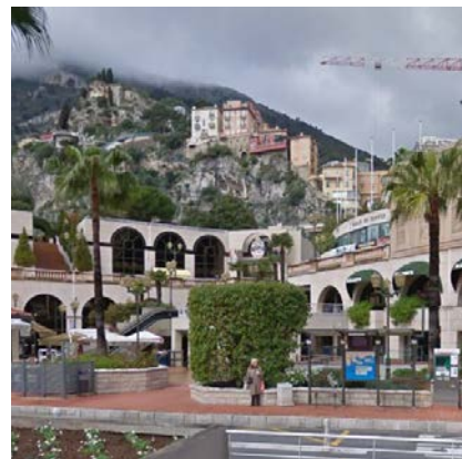
234 - Espace Léo Ferré & Centre Commercial de Fontvieille
